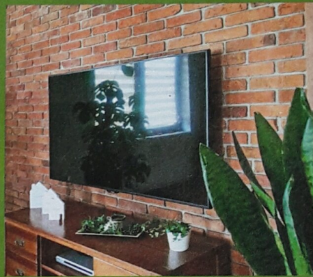
13 Płytki z cegły rozbiórkowej przyklejone do ściany i uzupełnione grubą spoiną do złudzenia przypominają prawdziwy ceglany mur
