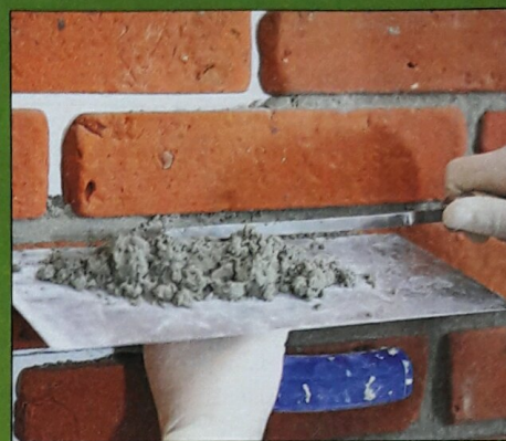
10 Masę wciskamy między płytki za pomocą fugówki. Również tym narzędziem wygładzamy ją i nadajemy kształt fugdy (może być wklęsła lub zlicowana z płytkami)
