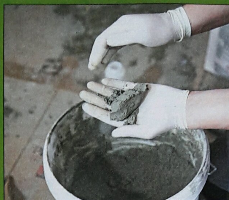
9 Gdy klej wyschnie, możemy zacząć fugowanie. Zaprawa do spoinowania powinna być plastyczna i mieć konsystencję wilgotnej ziemi
