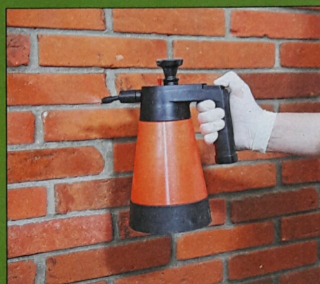
12 Po całkowitym wyschnięciu kleju i spoin (około 14 dni) ścianę możemy zaimpregnować. Ochroni to ją przed ewentualnymi zabrudzeniami
