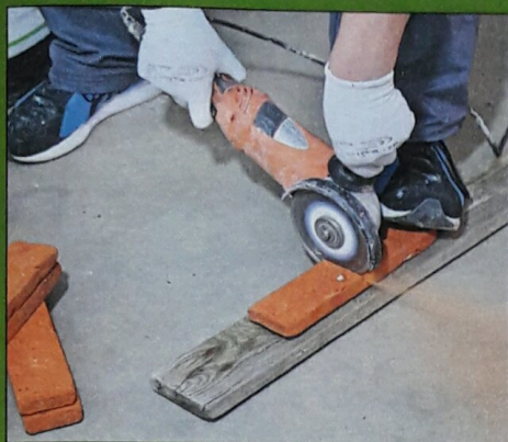
8 Płytki docinamy przy użyciu szlifierki kątovej i doklejamy w puste miejsca
